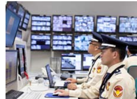
震度や被害状況を管理し、緊急活動をするスタッフや居住者に正確な情報を流す防災センター。（*）
